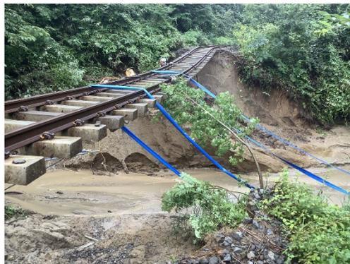
画像7 大雨災害によって崩壊した外ヶ浜町を通る鉄道線
